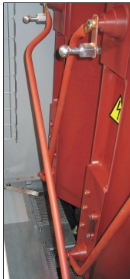
Рис. 1: Крепление кабелей ВН
