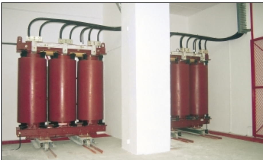
Стандартные присоединения ВН и НН сверху
